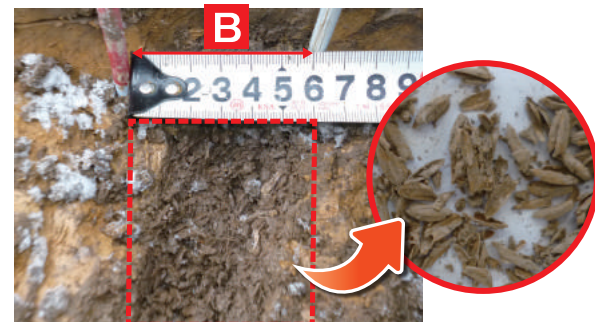
(ドレンレイヤー施工後10年経過地区での調査)
